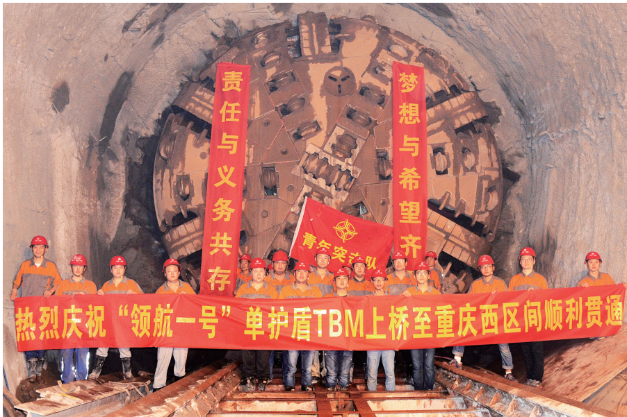
“领航一号”单护盾TBM上桥至重庆西区间隧道顺利贯通
