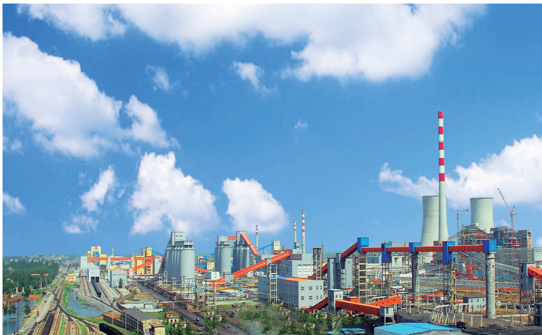
“2015中国化工潜力园区十强”临涣工业园
