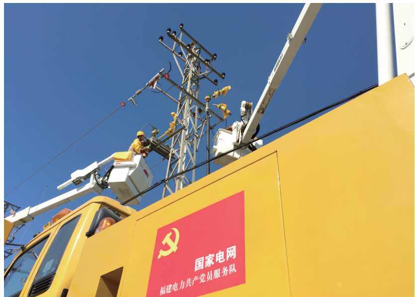
停电作业,保障居民用电。 国网石狮市供电公司共产党员服务队开展不停电作业,保障居民用电。 许伟哲摄
