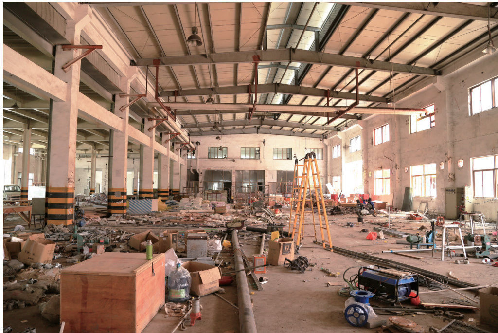
宁波当地最大的漂染园区厂房(二期)正在改造成众创园
