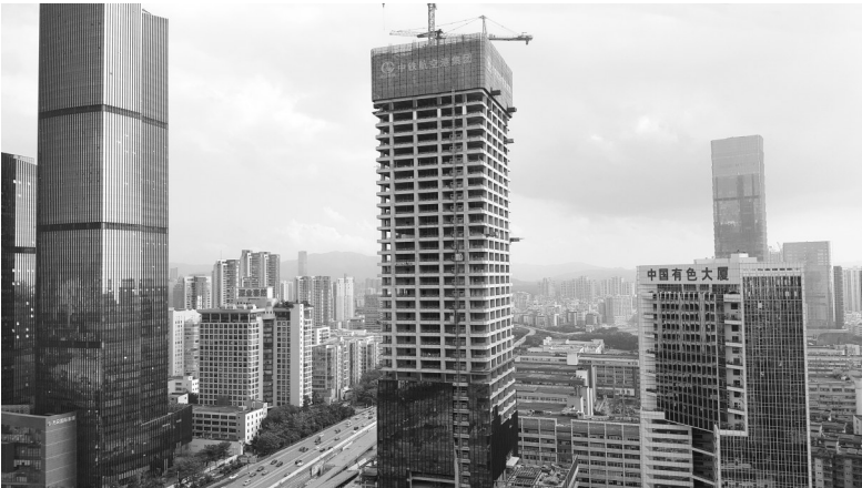
地铁汇通大厦施工全貌
