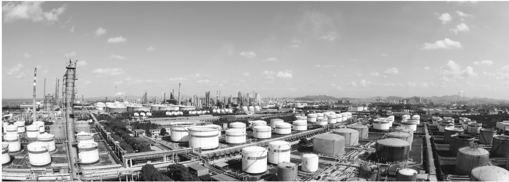
镇海炼化罐区全景
