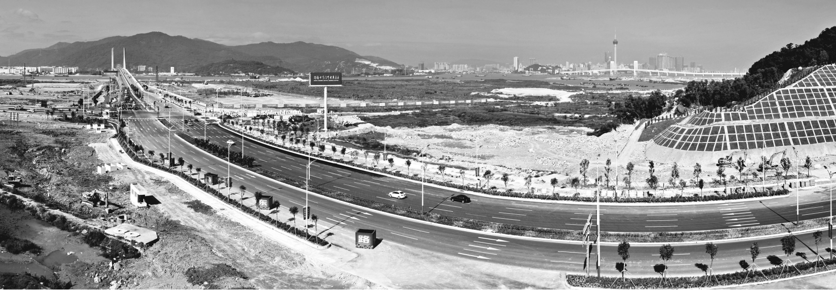
由中冶集团总承包建设的珠海横琴岛市政基础设施及地下综合管廊项目
