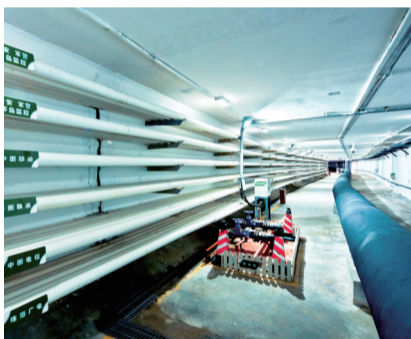
由中冶集团设计承建的横琴地下综合管廊
