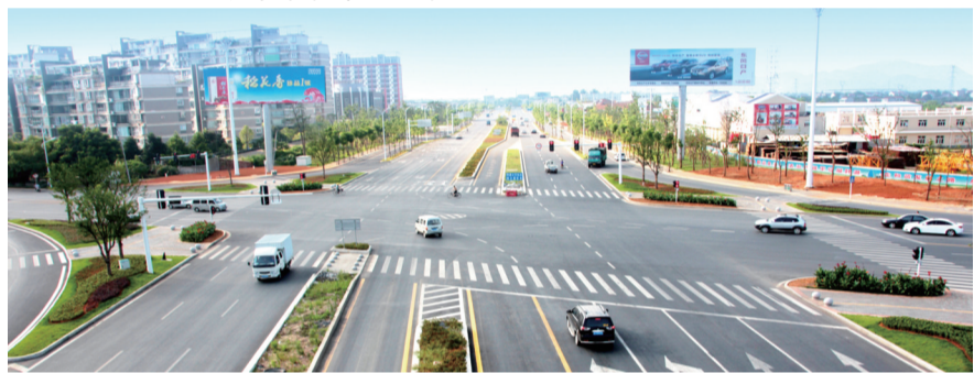
常德市常德大道改扩建工程
