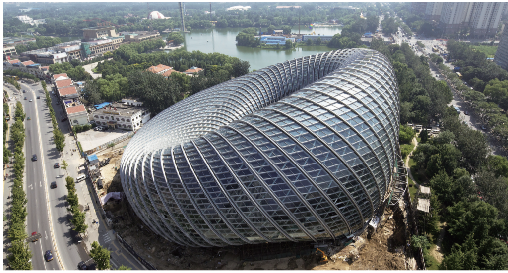
凤凰国际传媒中心工程2011年获得中国建筑钢结构金奖,是中国建筑钢结构行业工程质量的最高荣誉奖
