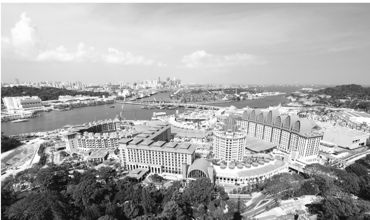
中冶集团承建的新加坡环球影城项目
