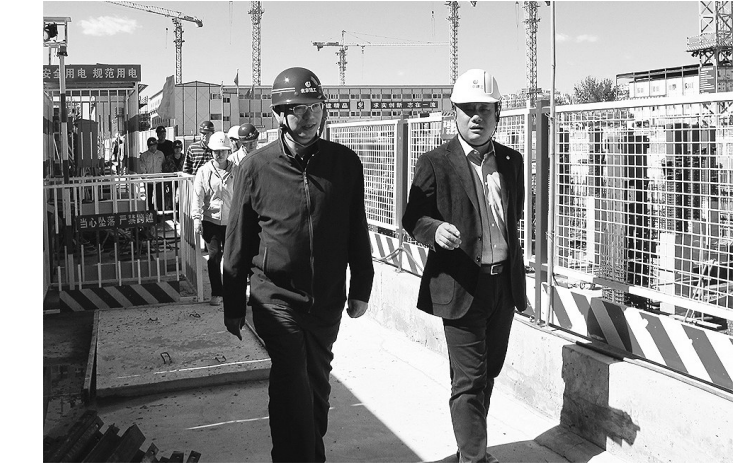
李檀总经理在施工现场调研(右二)
