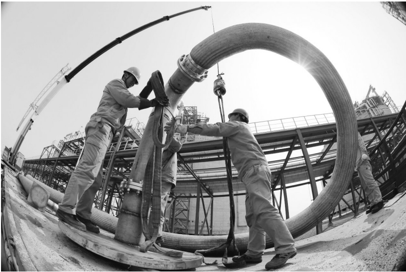
中国石化天然气广西北海LNG建设者。 孙劲松 寸学萍/摄
