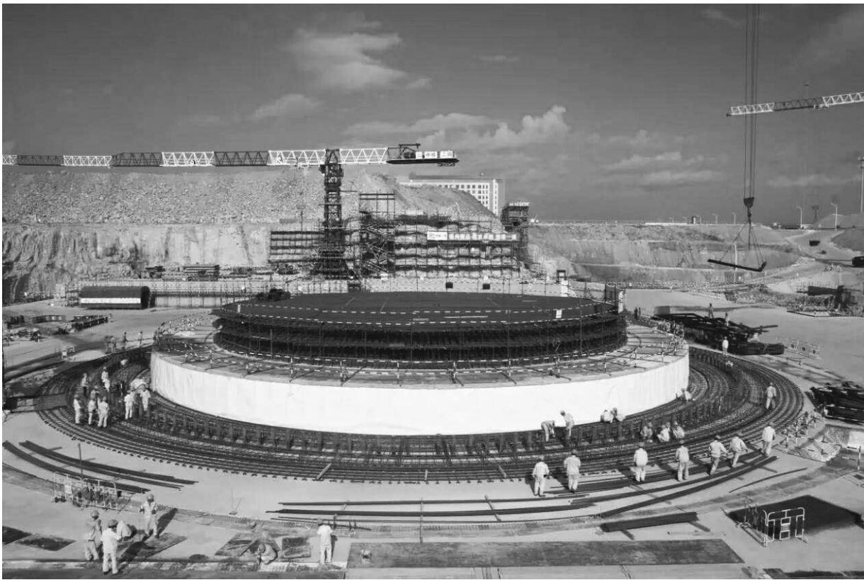
华龙一号示范工程福清6号机组筏基施工
