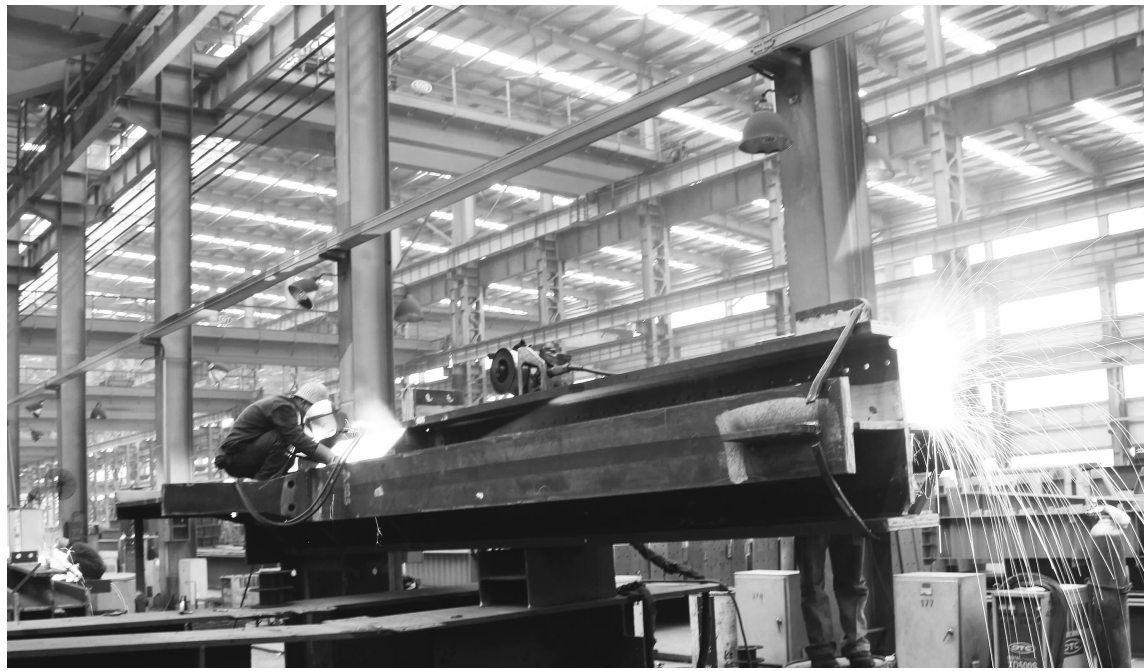
北京地铁 16 号线车辆基地构件正在加紧制作,部分构件制作完毕,可望近期实现发货。
