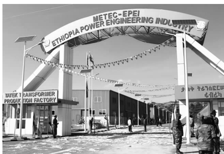
2015年6月,保利科技承建的埃塞俄比亚变压器生产线正式竣工交付
