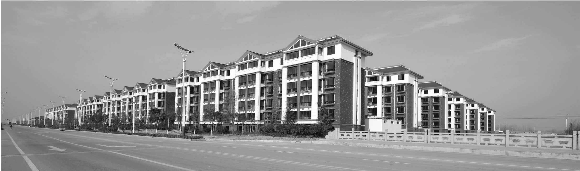
沛县杨屯镇压煤村庄搬迁新居 李抗/摄
