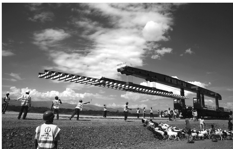
埃塞吉布提铁路开始铺轨——中国铁路标准昂首走向世界。刘渝/摄
