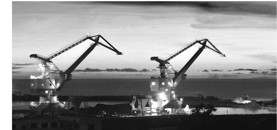
中国电建(水电八局承建的印尼亚齐电站煤港)
