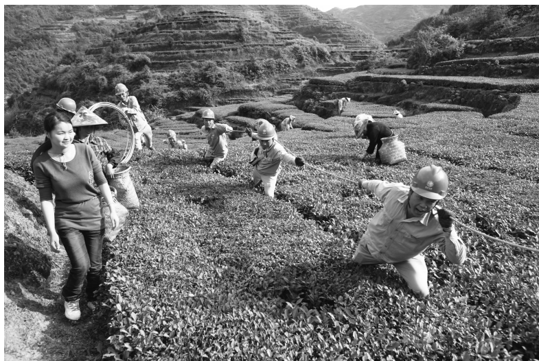
安溪供电公司在西坪镇架设线路,保障当地茶农生产用电。吴昌平/摄
