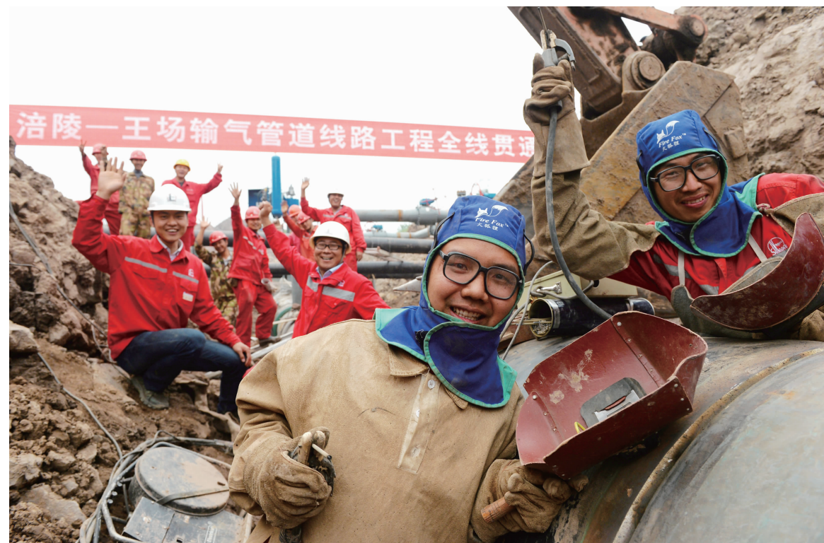
4月22日18时15分,随着涪陵—王场输气管道4号阀室最后一道焊口连头完成,国内首条大口径高压页岩气外输管道实现全线贯通。涪陵—王场输气管道始于重庆市涪陵区白涛工业园区,止于重庆市石柱县王场镇,与川气东送管道相连,管道全长136.5公里,设计输气量60亿立方米/年,总投资逾18亿元。自2014年8月15日打火开焊以来,中石化重庆天然气管道公司组织各参建队伍克服山区作业重重困难,抢工期,赶进度,高质量完成管道全线贯通任务,为涪陵页岩气外输管道工程投产奠定了坚实基础。图为4月22日涪陵页岩气外输管道最后一枪焊好贯通后现场施工人员在欢呼雀跃。 胡庆明/摄
