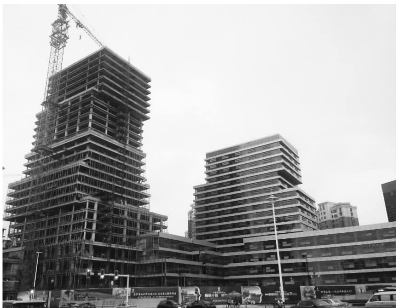
由华兴公司承建的中豪写字楼工程,钢构作用功不可没。
