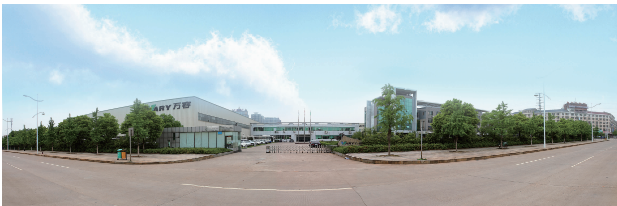
万容环保科技厂区
