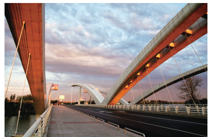
广济路大桥飞跨京杭大运河
