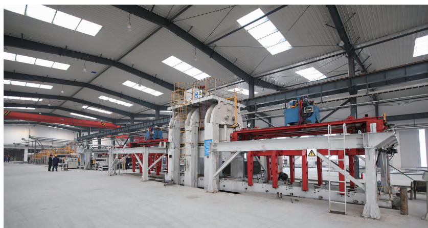
亳州海创新材料公司新型板材生产线
