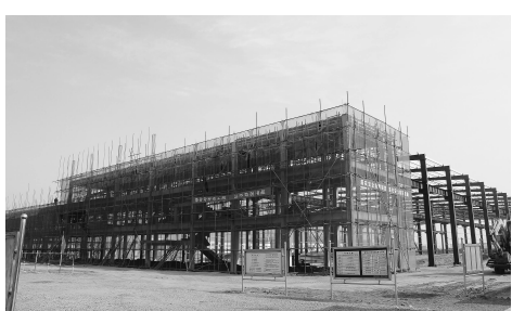
中煤科工施工工地现场
