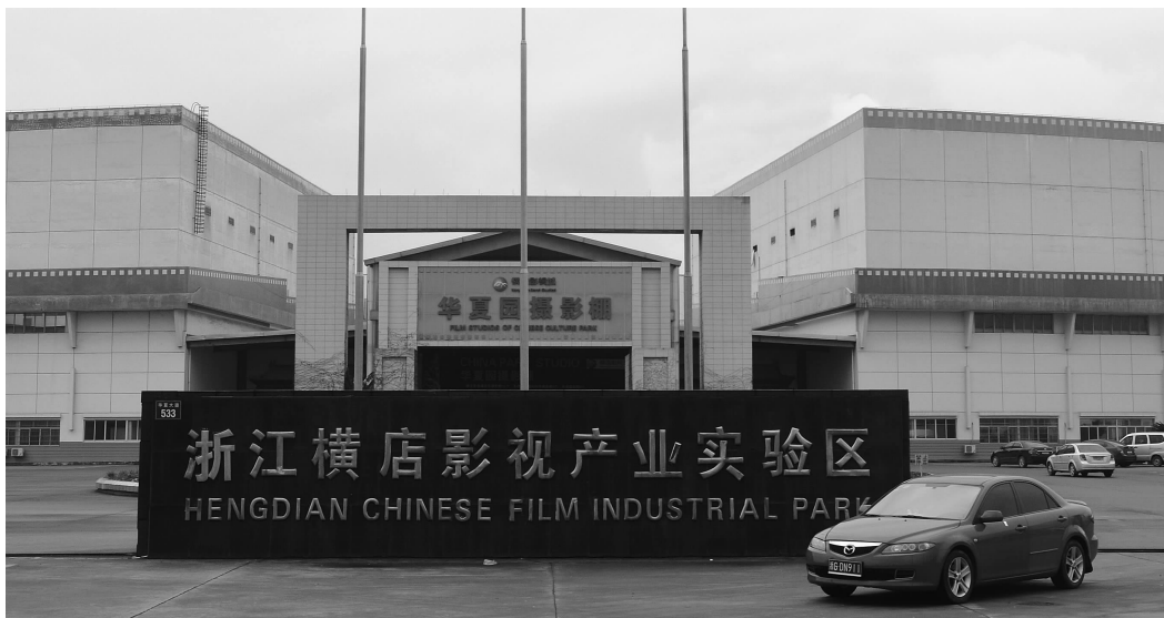
从目前已建成的影视基地运行情况看，除几家非常成熟的外，80%以上都处于亏损状态。
