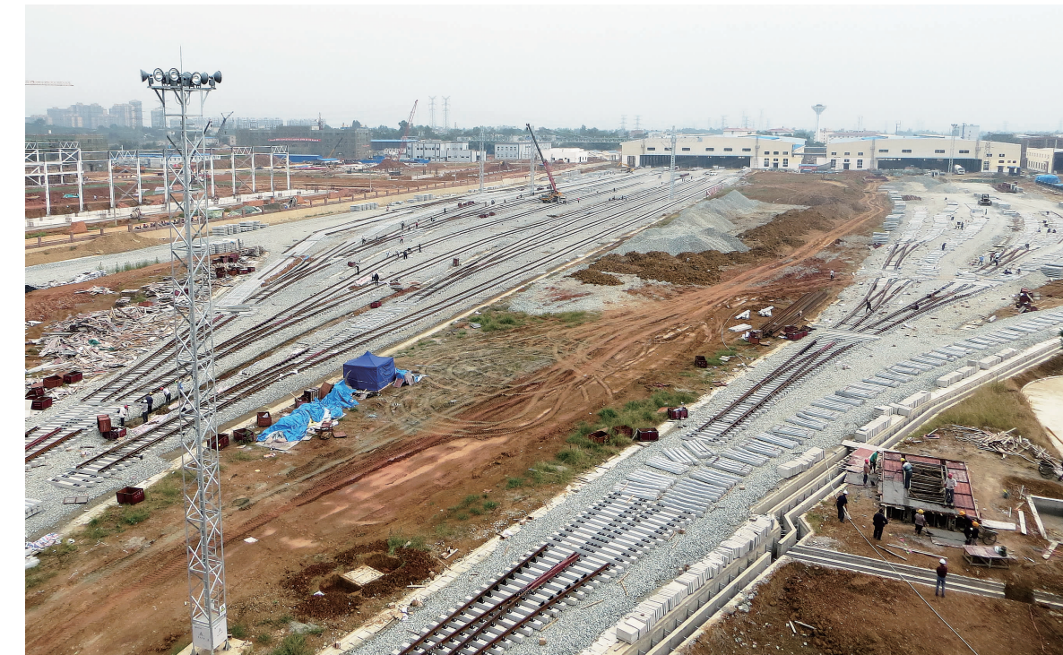
安徽首批 PPP 项目建设现场
