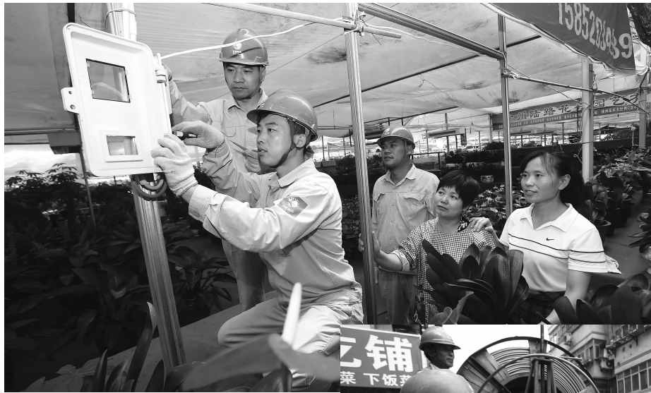
徐州供电人员在花木大世界市场进行送电施工
