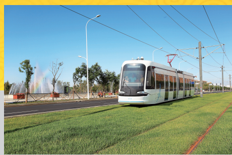
沈阳市浑南新区现代有轨电车项目连续获得“辽宁省市政金杯示范工程”、“沈阳市市政金杯工程”等荣誉称号。
