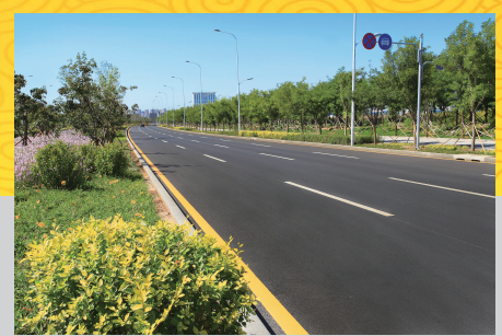
沈阳市浑南新城市政道路及排水工程被授予“2013年沈阳市市政金杯示范工程”荣誉称号。
