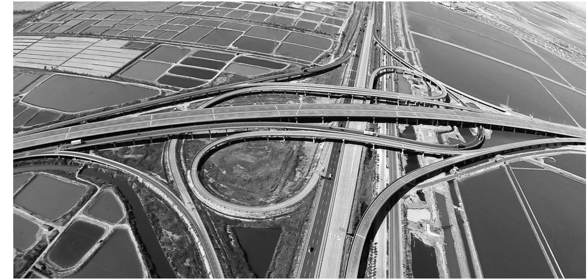
2010年,路桥建承建国道112线5合同(滨保高速汉沽北互通立交)项目,该项目是公司自建以来承揽到的工程体量最大的大型枢纽式立交工程。
