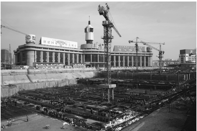
在天津站交通枢纽5合同中,路桥建先后打响了地下帷幕施作、土方开挖、中心岛结构、保留土体结构混凝土浇筑等四大战役,优质高速地完成建设任务,展示了企业组织超大深基坑作业的施工实力。
