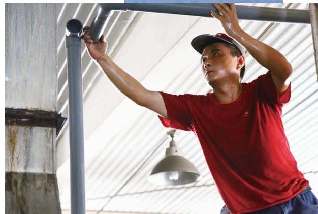
高温下,化纤车间保全队长范宜刚在安装管道
