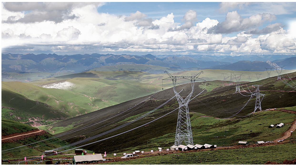
川藏联网工程现场 谢风华/摄
