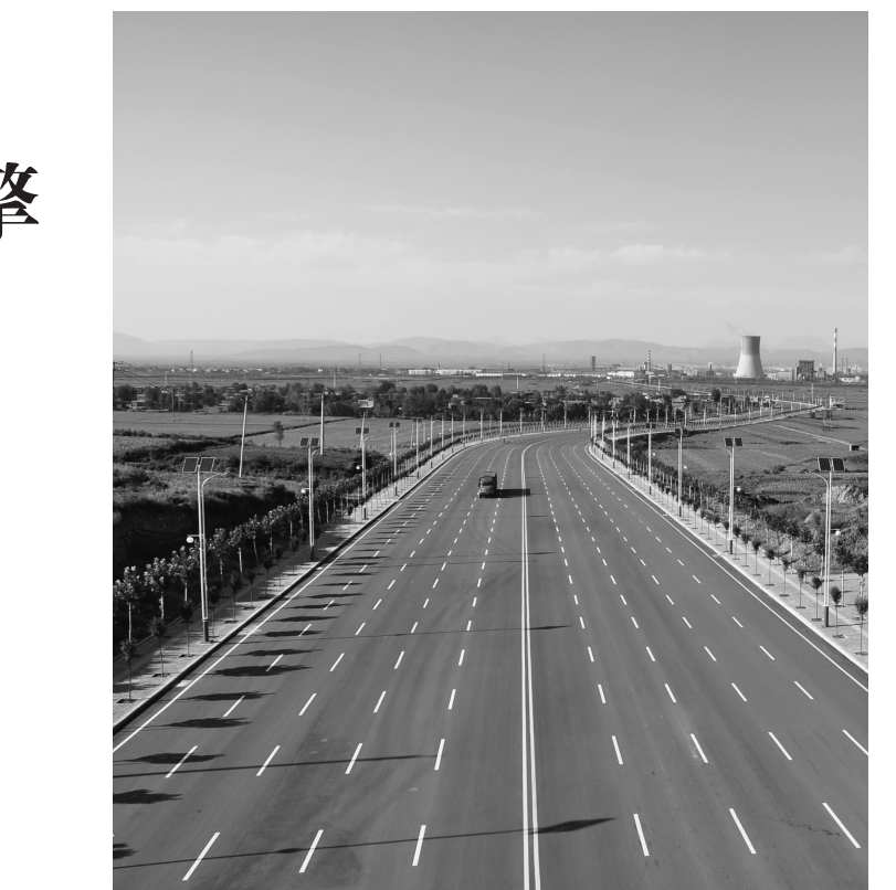
集聚区水、电、气、路、热、通讯不断完善
