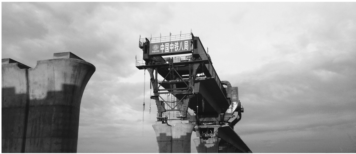
铺架铁骑 景春林/摄
