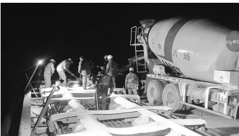
洪水和顺河特大桥梁道床浇筑 徐军杰/摄
