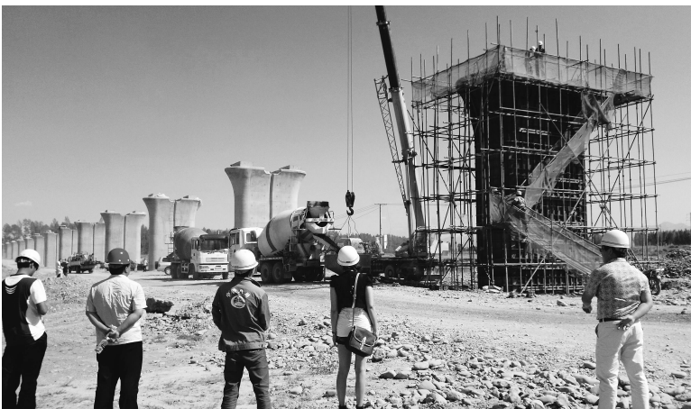
李尤村特大桥梁最后一个墩身施工 景春林/摄
