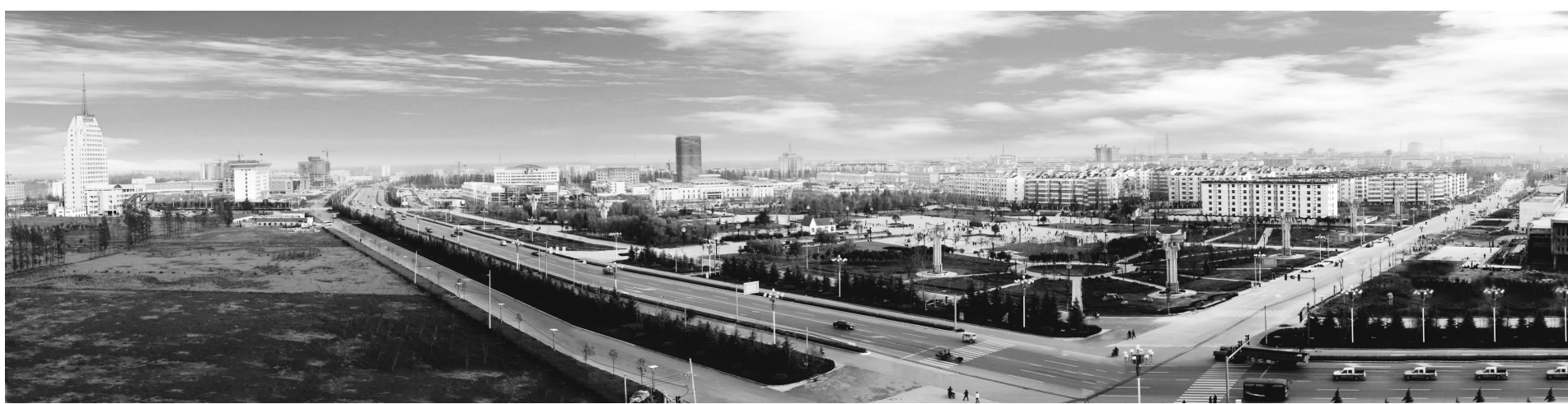
邳州经济开发区整体城市建设
