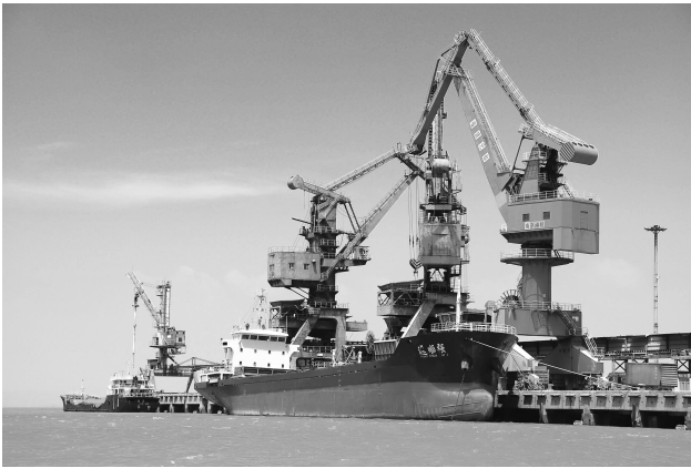
元洪投资区元洪国际港口散杂货码头
