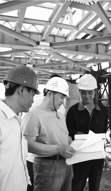
工程技术人员对工程进行调度
