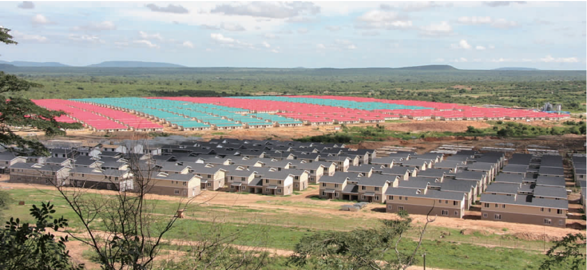
北新建材赞比亚公共住宅项目
