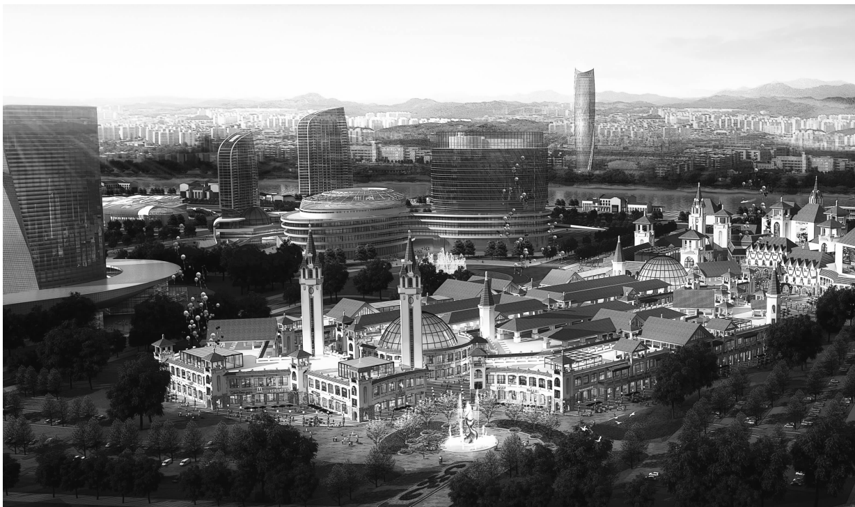
招商引资 15 亿美元的奥特莱斯芭蕾雨项目正在紧张施工,风情购物小镇主体已经全部封顶。
