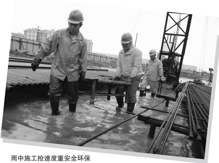
雨中施工抢速度重安全环保
