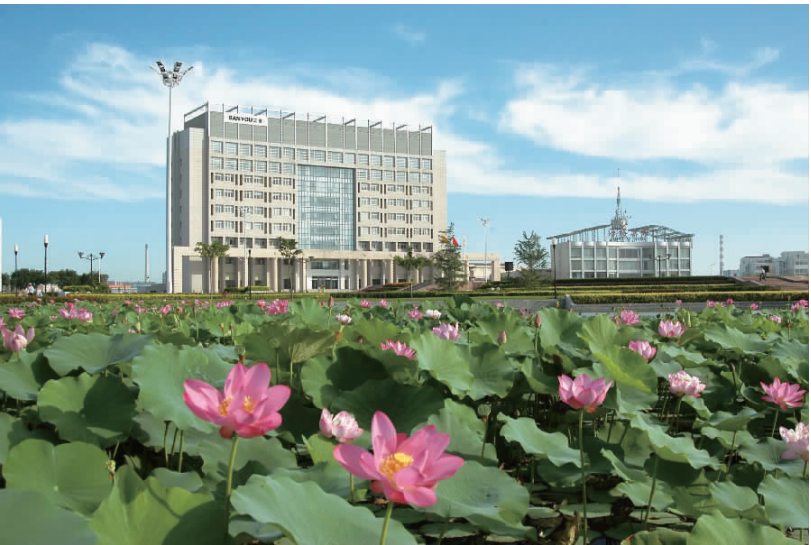
三友集团办公大楼
