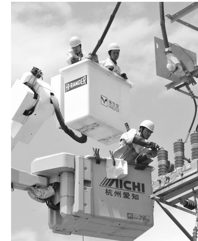
晋江市供电公司开展带电作业,服务地方经济发展。 曹晶/摄
