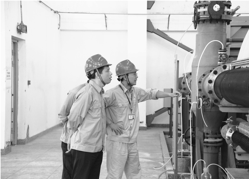
石化集团董事长林立(左)、副总经理朱玉武到烧碱电解槽指导工作
