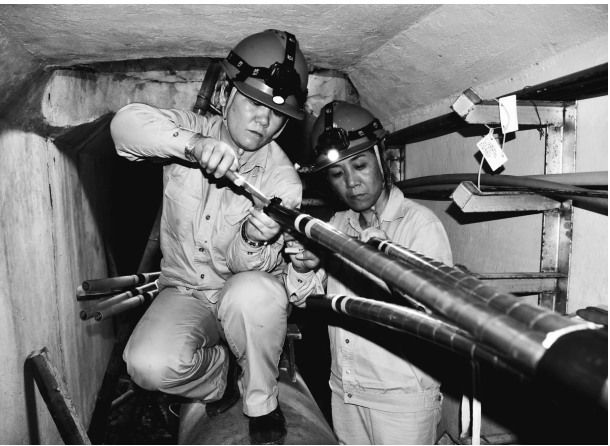
在狭窄的电缆通道里,电缆女工只能蹲在排污管道上完成工作。图为郑云英和赵秀玲在闷热狭小的井下制作电缆连接头。
