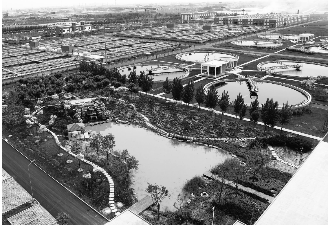
天津市城建集团承建的张贵庄污水处理厂荣获2013年度鲁班奖
