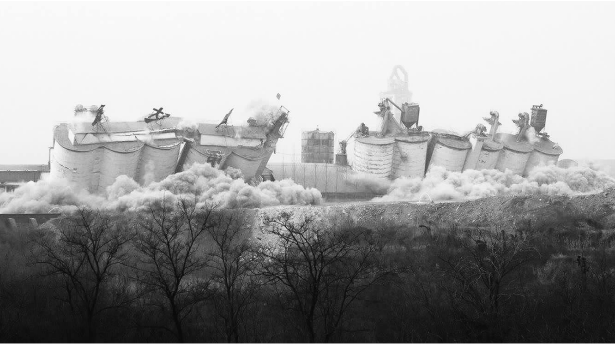
石家庄水泥厂被爆破拆除瞬间
