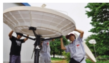
普天工程人员在老挝搭建卫星接收天线。
