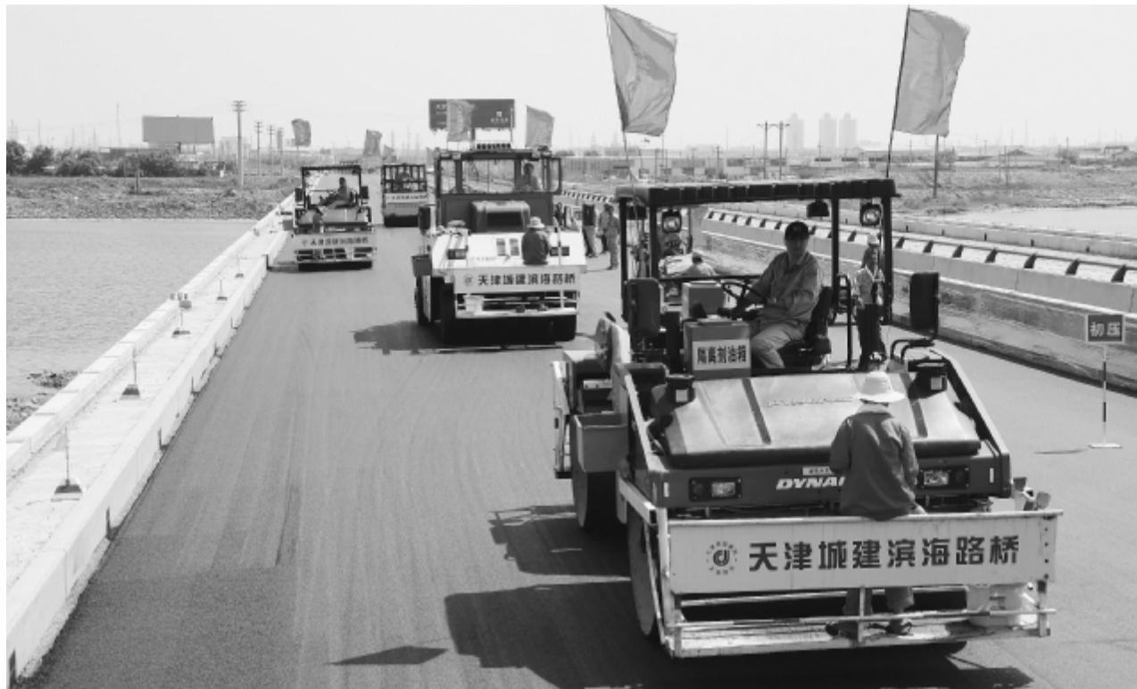
滨海路桥在东风桥施工现场紧锣密鼓加紧施工
