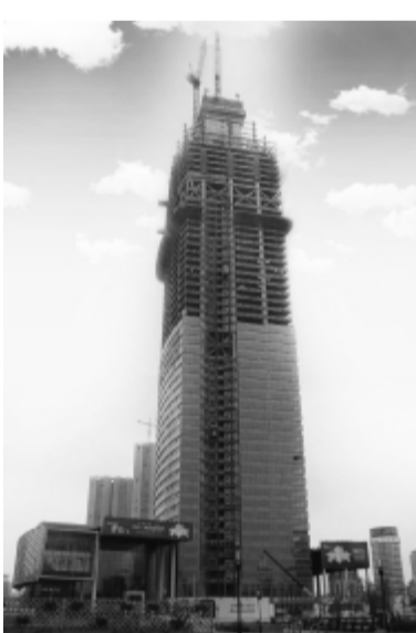
沈阳恒隆项目塔楼在建中
