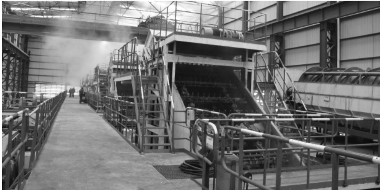
中粮屯河股份有限公司制糖车间正在机械化生产。
